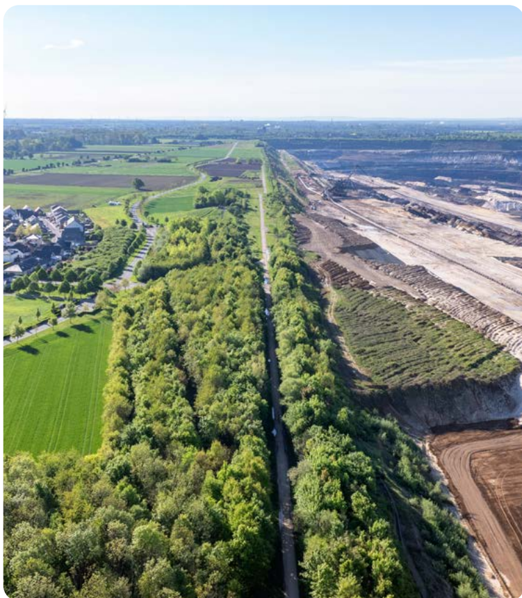
Die Abbruchkante bei Schophoven mit dem künftigen Hafenbecken
